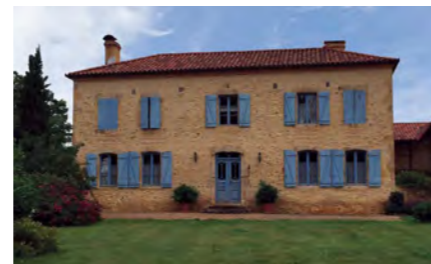
La Tursanaise > un volume rectangulaire, un toit ramassé à 4 pans, des tuiles creuses et rouges de type Canal, des petites fenêtres symétriques aux volets en bois peint, une façade dans les tons sable.
