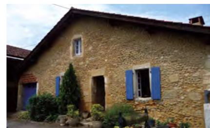
La Chalossaise > le toit n'a plus que 2 pans.
