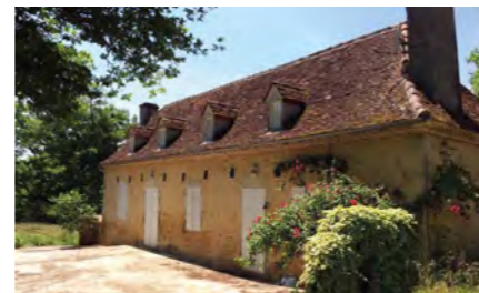
La Béarnaise > les pentes du toit se raidissent et s'allongent, avec des tuiles plates de type Picon.
